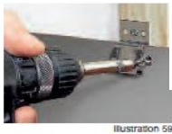
Fixation unique formant point fixe en milieu de clins
