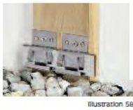
Pose des pattes agrafes de départ
