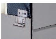
Angle sortant avec jeu de dilatation
