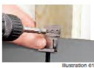
Pose de la patte agrafe supérieur à la jonction des clins
